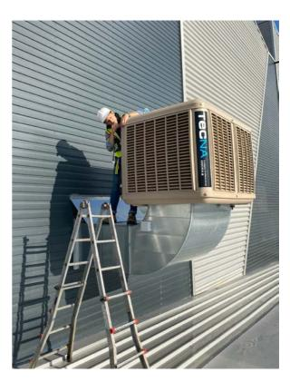
Para la climatización de la nave de estampación NISSAN, TECNA ha suministrado equipos evaporativos, en concreto, 18 Unidades QA-500 integradas en el Sistema de control domótico integrado INTELLITOUCH.
