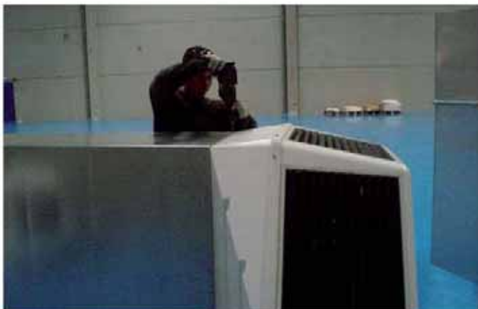
Colocar el plenum en el conducto
