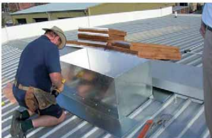
Atornillar el vierteaguas al conducto
