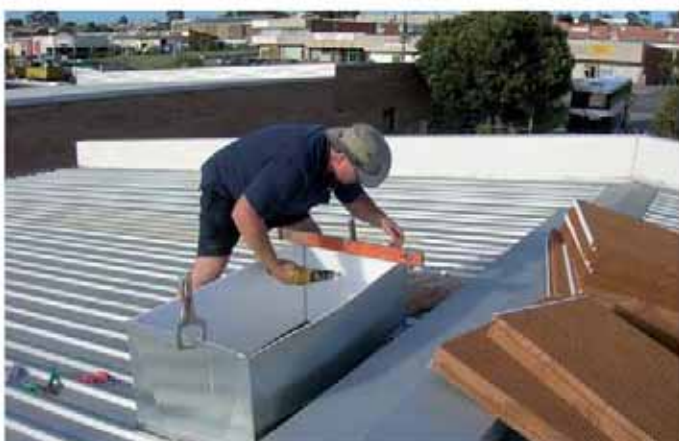
Importante nivelar el conducto
