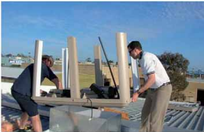
Montar la base sobre el conducto
