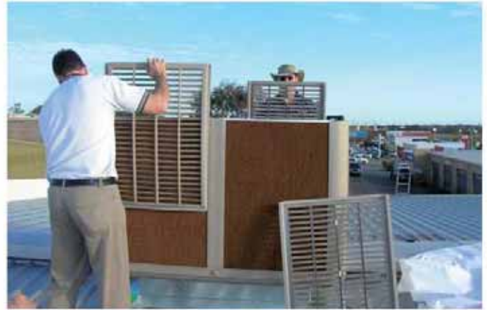
Colocar las rejillas
