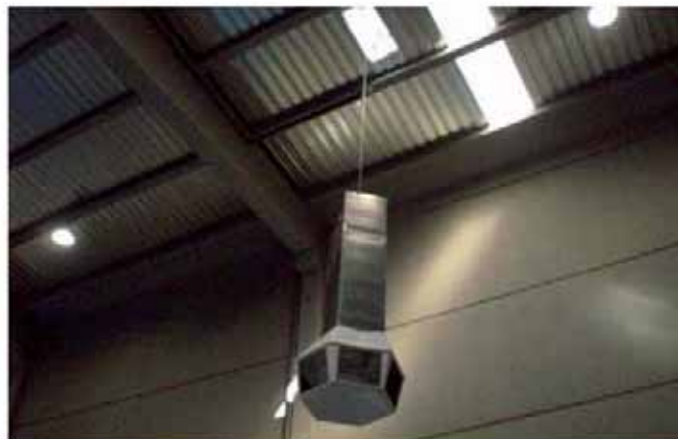
Subiendo el conducto en una nave de 18 m. de altura
