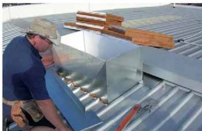
Impermeabilizar bien es muy importante
