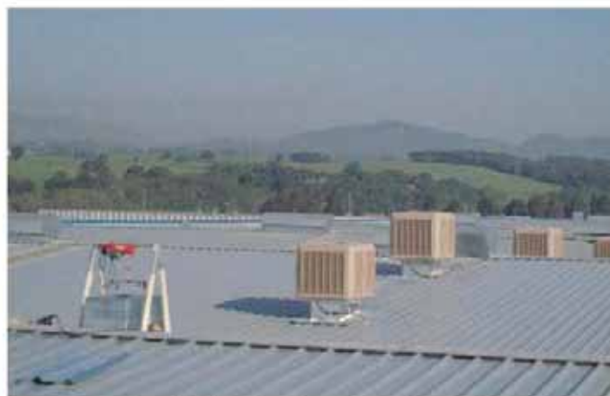
La polea eléctrica ahorra tiempo de montaje
