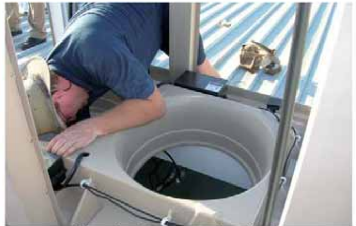
Fijar la base al conducto y preparar los cables eléctricos
