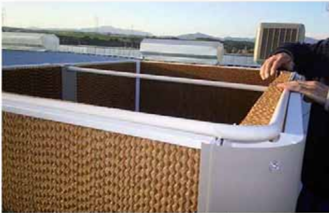
Colocación del tubo distribuidor de agua
