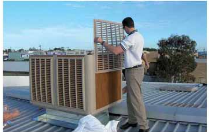
Colocar las rejillas
