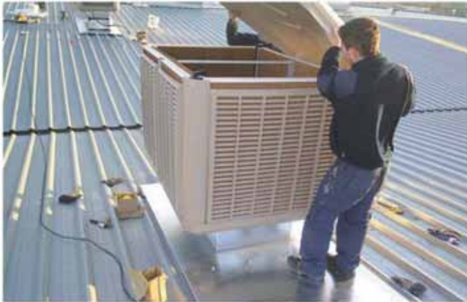
Detalle del montaje y de la plancha de impermeabilización
