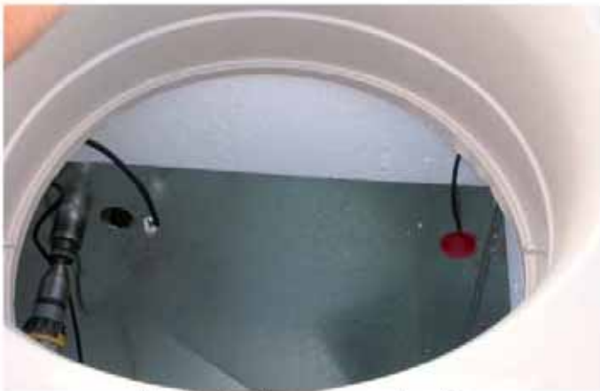
Taladrar el conducto para pasar los cables
