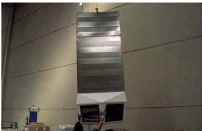
El conducto con su plenum ya montado se sube verticalmente desde el tejado
