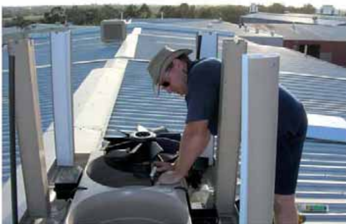
Colocar y conectar los motores
