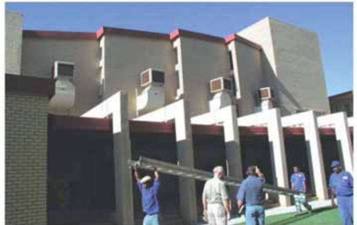
Fotos evaporativos verticales CA 255 D, colocados en pared
