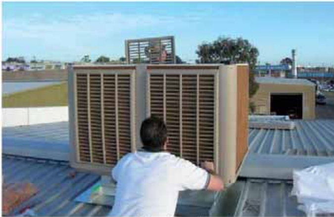
Colocar las rejillas
