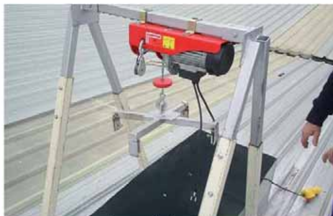
Maquinillo para subir los conductos al tejado
