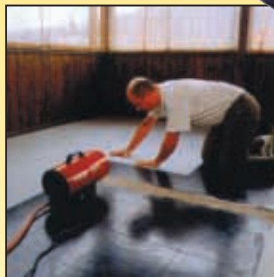
Secado de yesos y pintura
