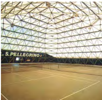
Pabellones polideportivos. Distribuye homogéneamente el calor en todo el ambiente
