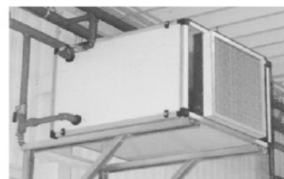
Aerotermino instalado en una nave industrial con rejilla de impulsión
