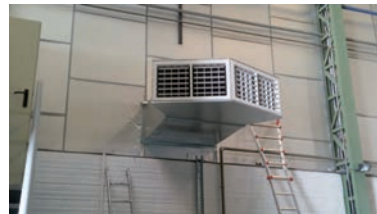
*Plenum difusor lateral de dos salidas
