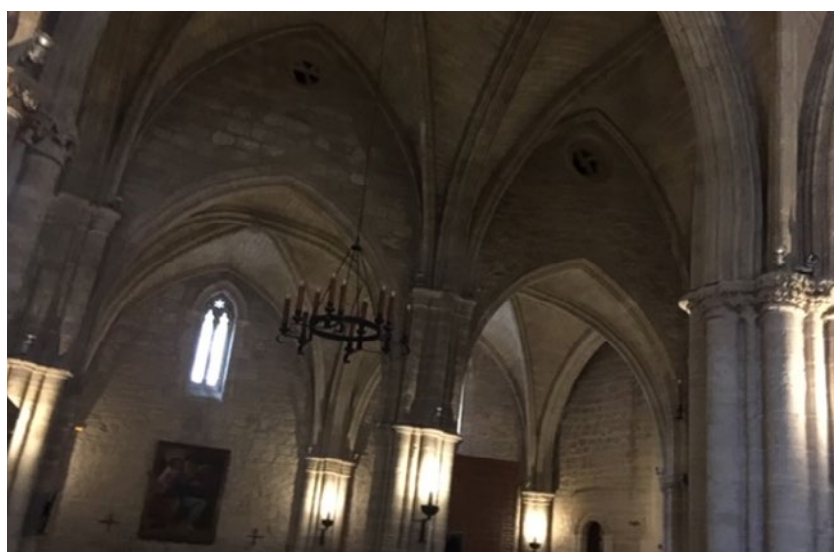
Detalle de los orificios circulares en bóvedas para la extracción del aire, favoreciendo renovaciones.
