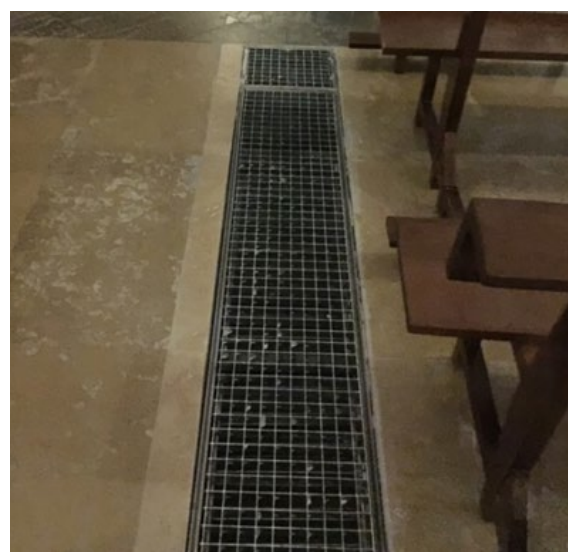
Detalle de las rejillas en suelo para la impulsión del aire
