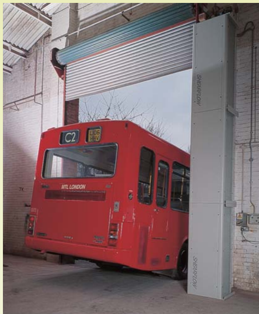
Ejemplo: 3 Módulos MI -1.500 colocados en Serie para cubrir una puerta de 4,5 m. de anchura.
