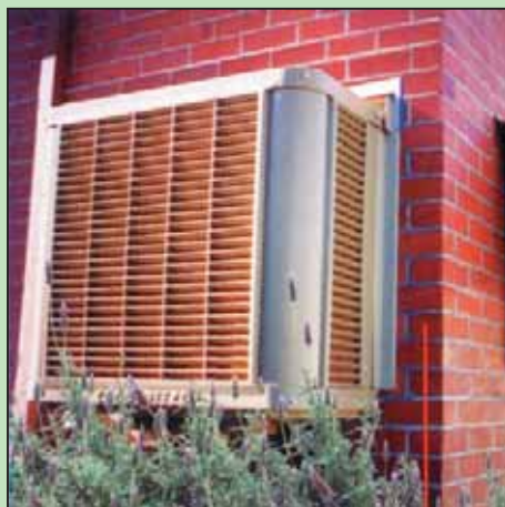
Instalación en Viviendas
