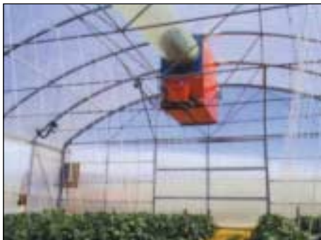
Aplicación colgado en invernaderos y con tubo de polietileno
