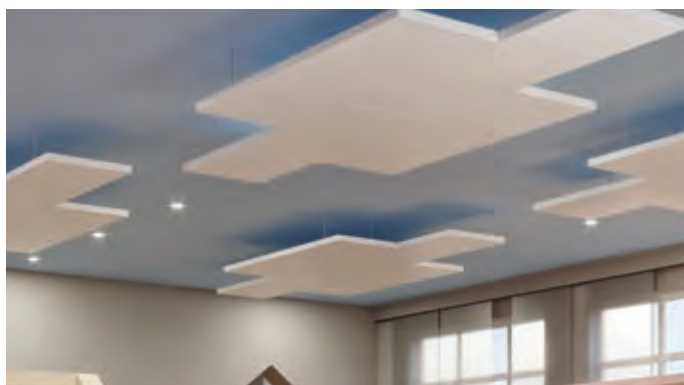
Exemplo de um jardim infantil com painel radiante a água TECNA SABIANA PULSAR
